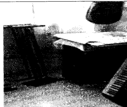
FOTO 10 y 11. Se observan deficiencias en la ubicación y mala disposición local del RACK de comunicaciones al interior de la construcción, su instalación se encuentra en un espacio que a su vez funciona como oficina de almacenamiento, situación que genera manipulación e inseguridad de los aparatos eléctricos y de comunicación, incumplimiento de lo contenido en las normas técnica RETIE (Reglamento Técnico de Instalaciones) e INCONTEC – NTC2050 Código eléctrico Colombiano).
