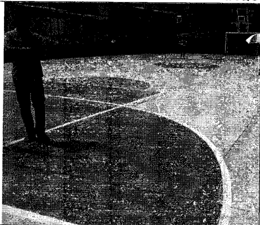
FOTOS 1 Y 2. Falta de afinado del piso en concreto, contaminado con mortero. Presenta fisuras longitudinales paralelas a las juntas de dilatación placa cancha. Situaciones con las cuales se aprecia deficiencias en la mano de obra utilizada.
