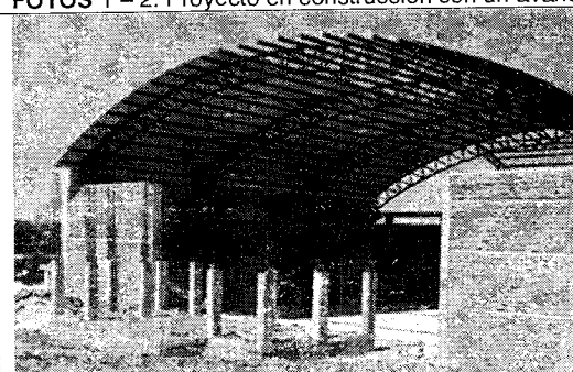
FOTOS 3 – 4 Estructuras en concreto y cubierta sin terminar.
