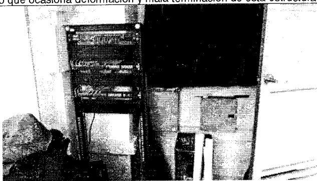
FOTO 10 y 11. Se observan deficiencias en la ubicación y mala disposición local del RACK de comunicaciones al interior de la construcción, su instalación se encuentra en un espacio que a su vez funciona como oficina de almacenamiento, situación que genera manipulación e inseguridad de los aparatos eléctricos y de comunicación, incumplimiento de lo contenido en las normas técnica RETIE (Reglamento Técnico de Instalaciones) e INCONTEC – NTC2050 Código eléctrico Colombiano).
