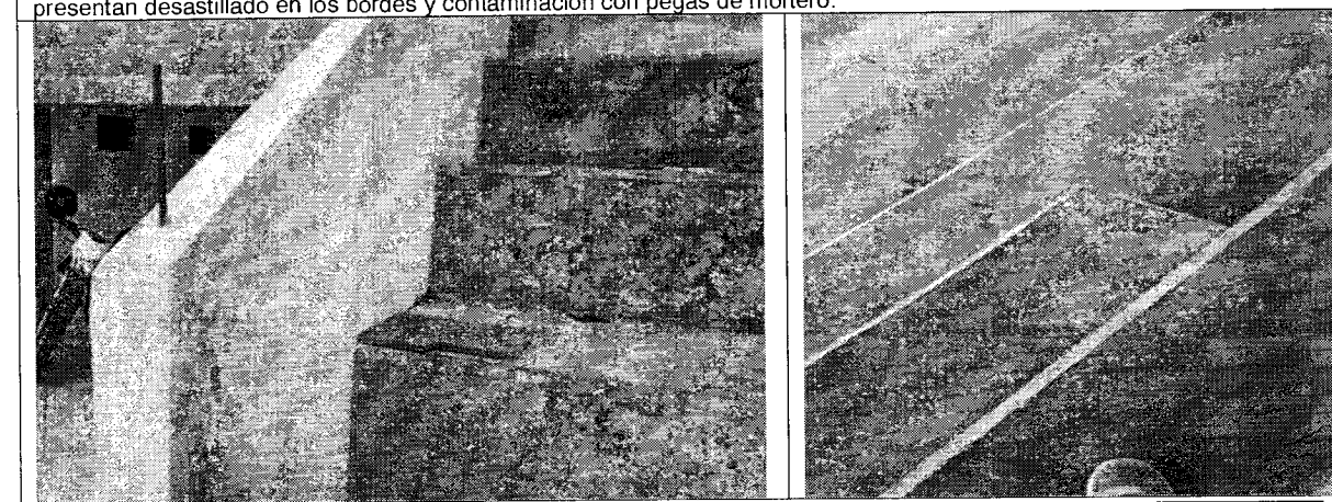
FOTOS 15 – 16 – 17. Falta perfilado y uniformidad en el acabado de la superficie de las graderías y escaleras, las cuales presentan desastillado en los bordes y contaminación con pegas de mortero.
