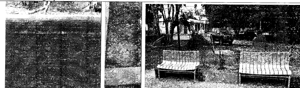
FOTOS 15 – 16 – 17. Acciones vandálicas y la falta de implementación del plan de sostenibilidad y mantenimiento han afectado el equipamiento urbano como bancas. La falta de funcionamiento de los puntos hidráulicos conlleva a la pérdida de la empedrización y arbolización del parque.
